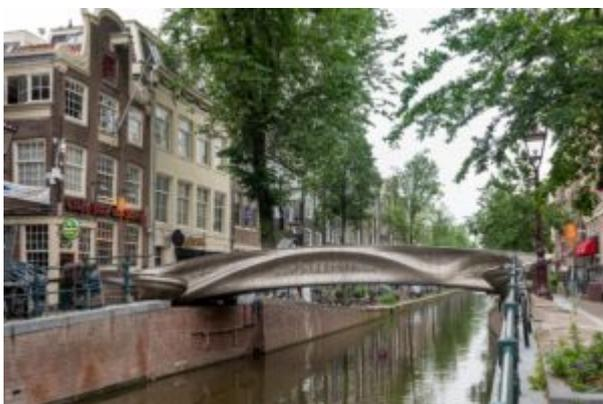
Gemeinsam haben die beiden Bauwerke, dass sie Schicht für Schicht aufgebaut wurden. Durch den Einsatz von Robotern waren selbst ausgiebige Rundungen kein Problem. Das Haus in Beckum (s. VDI nachrichten 45/2020) besitzt viele abgerundete Ecken, die
