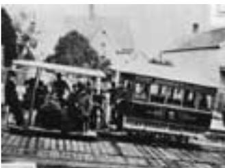
Quelques villes avaient également essayé la traction par câble là où il y avait des pentes importantes : cas de San-Francisco, dont les « cable cars » fonctionnent encore aujourd'hui. Les câbles étaient entraînés par une machine à vapeur, avant d'être ensuite électrifiés. Un système de ce
