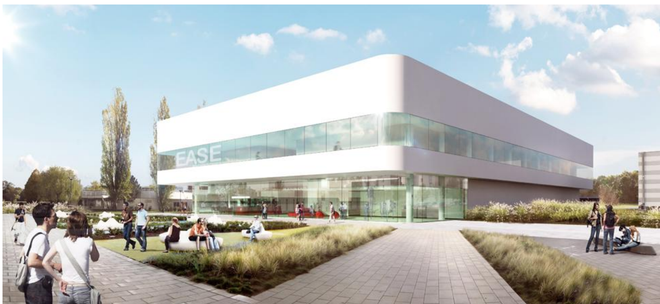
L'usine école EASE à Illkirch (67)
